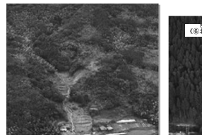
② 山口県 萩市 下湯平地区 (行方不明者 1名) 土石流
