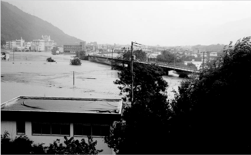
三加茂町山口谷付近浸水状況(平成16年10月 台風23号)
