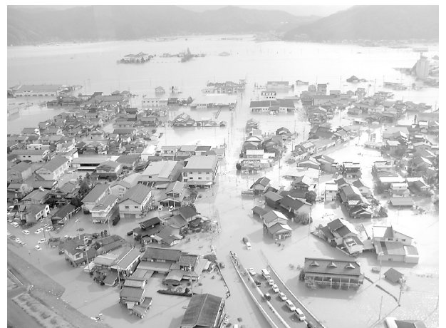
江本地区冠水状況（兵庫県豊岡市）
