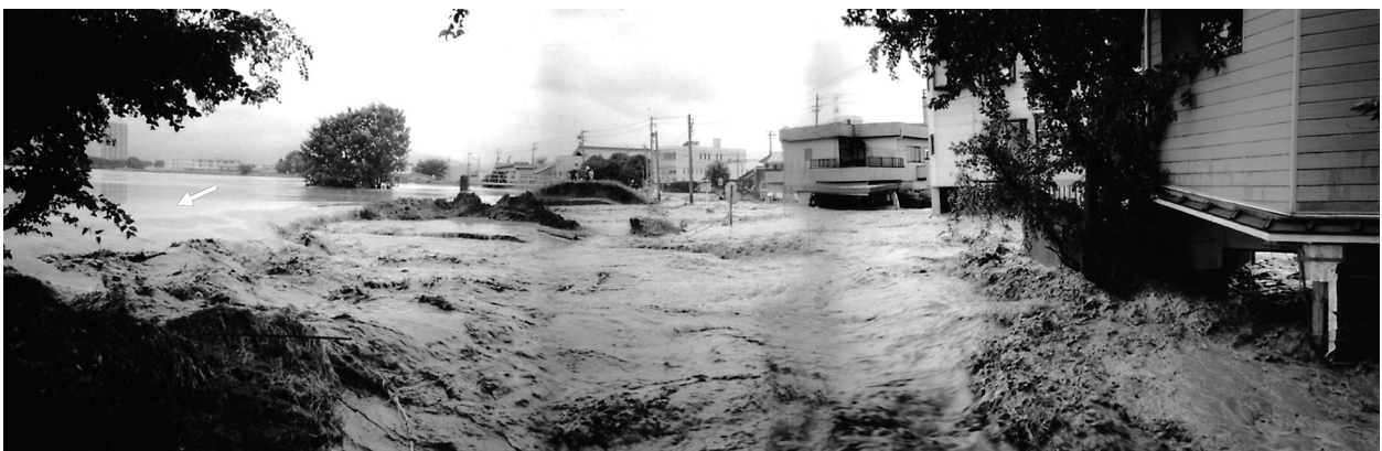
足羽川左岸破堤状況（福井県福井市）
