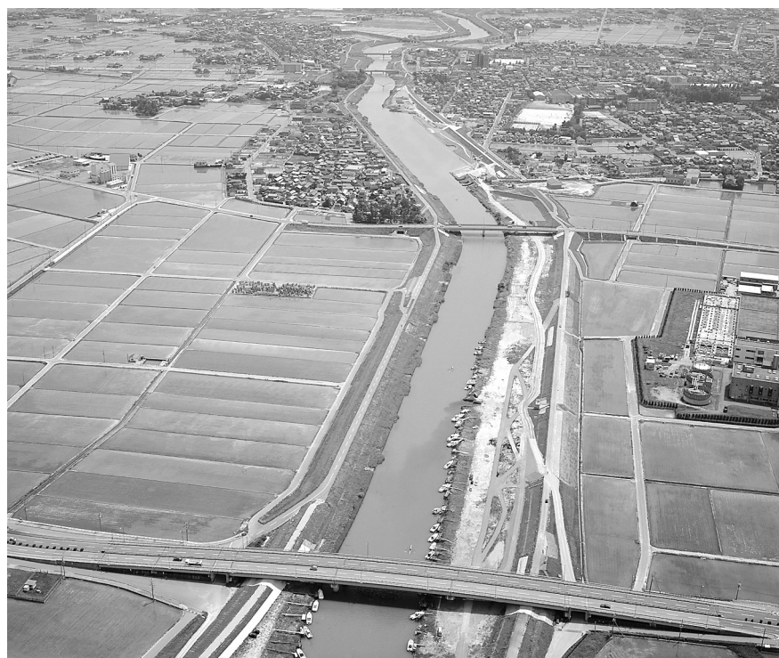
引堤が完成した梯川 (鶴ヶ島町～丸の内町地区) (北陸地方整備局提供)
