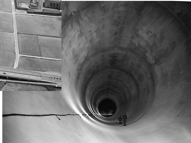
大津放水路 (1期区間) シールドトンネル (近畿地方整備局提供)
