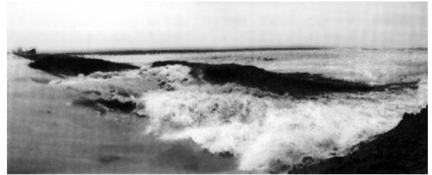
堤防爆破後の導流状況
