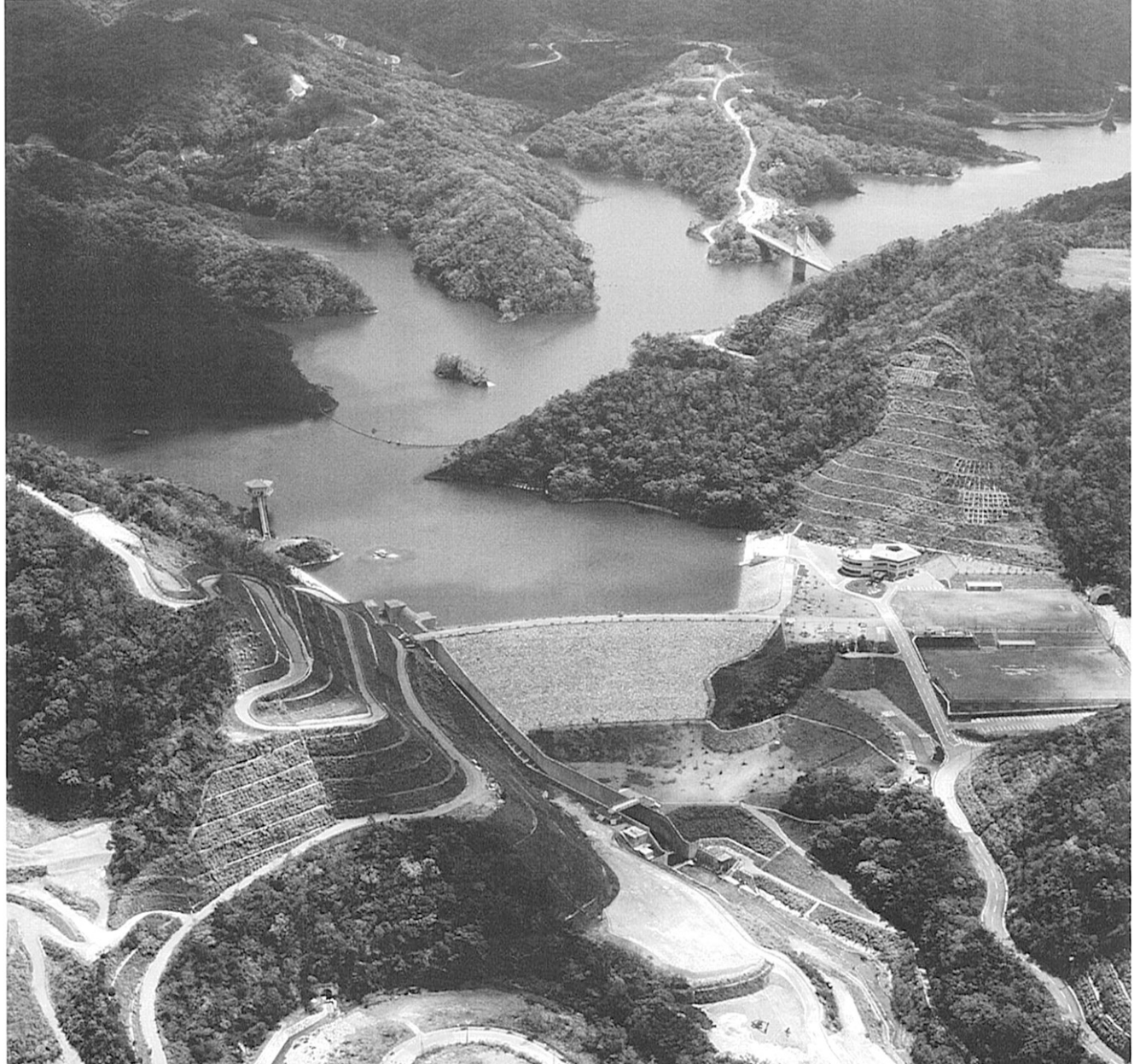
竣工した羽地ダム (沖縄総合事務局提供)
