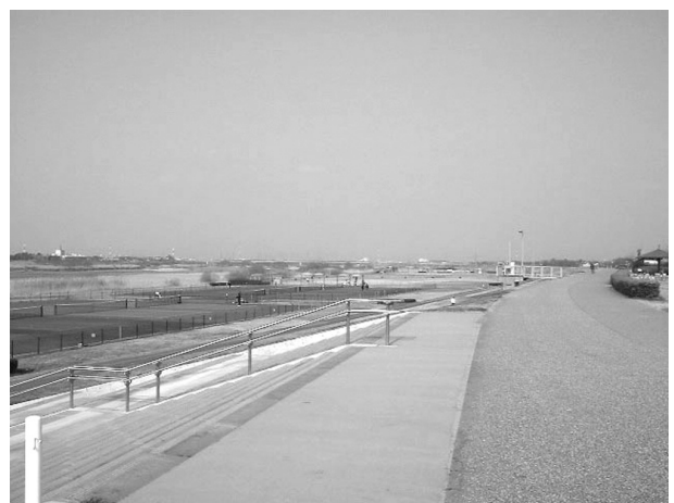
河口より5.0km付近の西尾緑地
