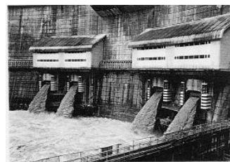
常用洪水吐より自然越流
