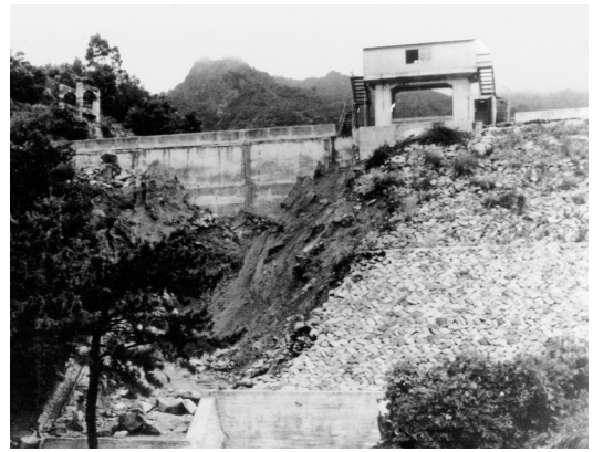
昭和36年 内海ダム堤体崩壊
