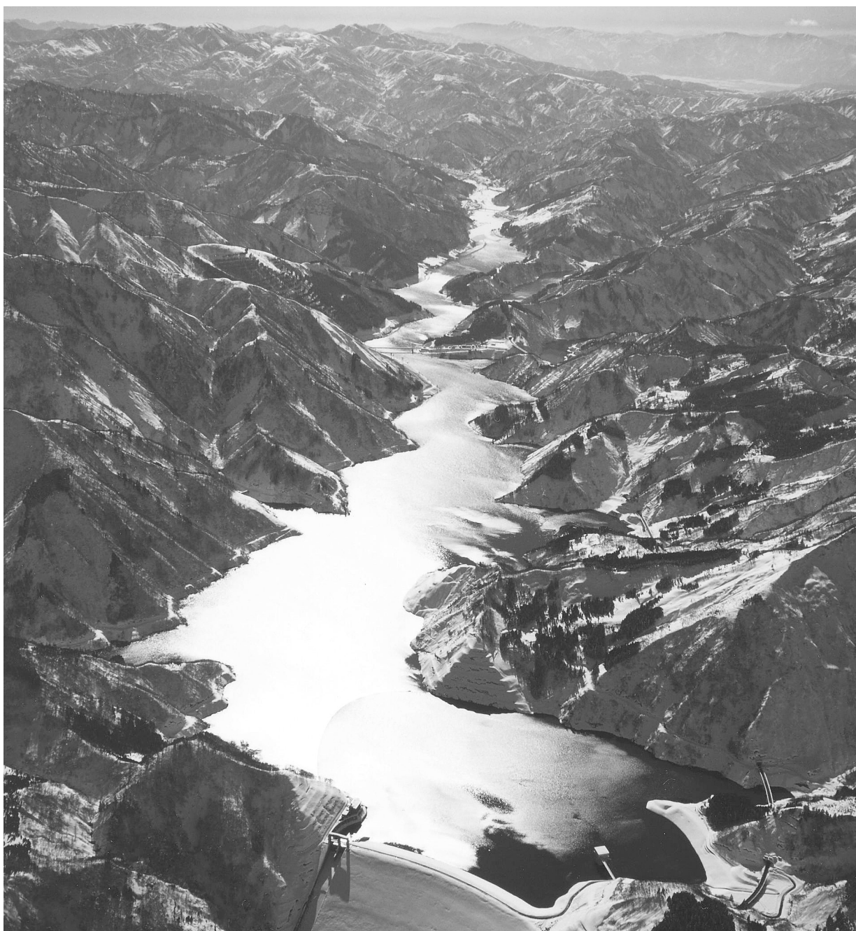
手取川ダムの雪景色 (北陸地方整備局提供)
