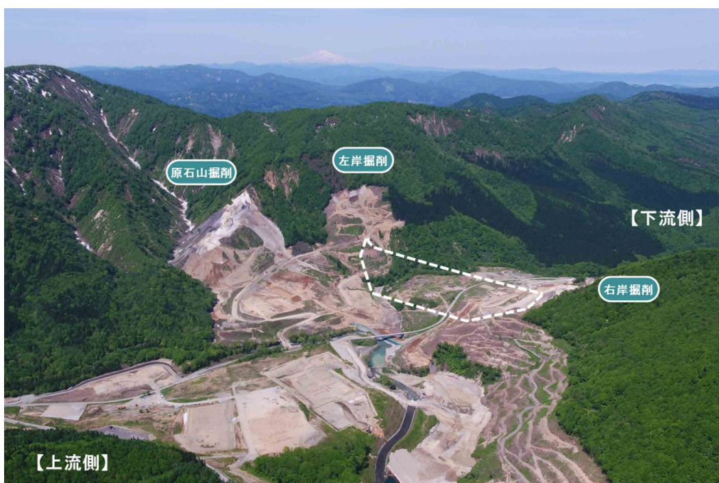
施工状況 上流側から望む（平成30年5月22日撮影）
