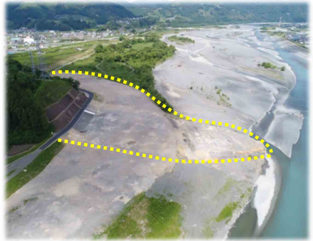
<写真-1>完成写真
