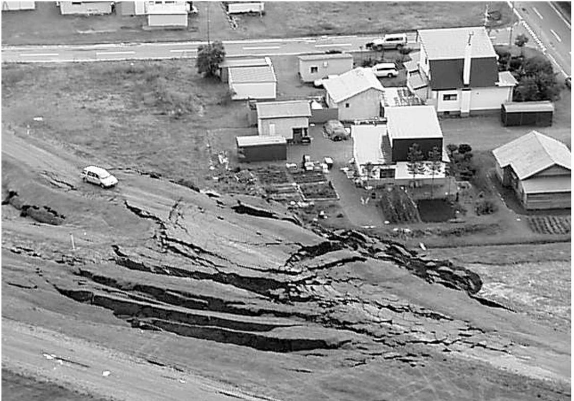
十勝川右岸大津築堤の被害状況
