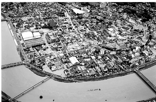
写真1 飯塚市街部の浸水状況（7月19日9時30分頃撮影）
