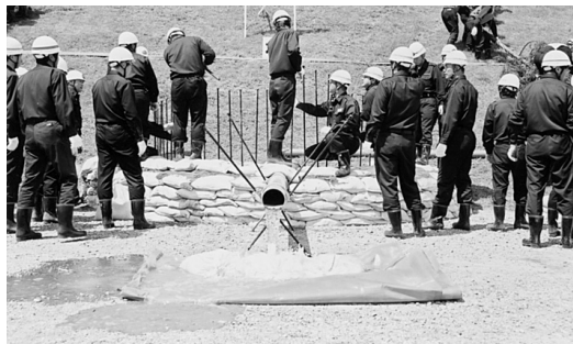
5月25日 信濃川・魚野川水防演習(月の輪工)
