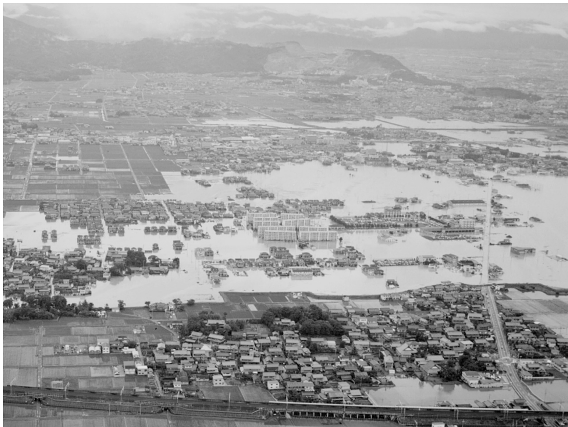
台風6号による出水被害（岐阜県大垣市）写真提供：中部地方整備局
