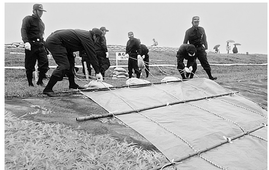
シート張り工を実施する水防団員 (利根川水系連合水防演習)
