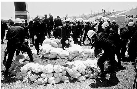
釜段工を実施する水防団員 (六角川・嘉瀬川・松浦川水防演習)
