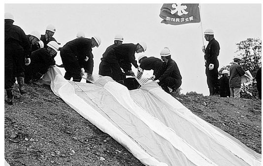
水防マット工を実施する水防団員(野洲川水防演習)
