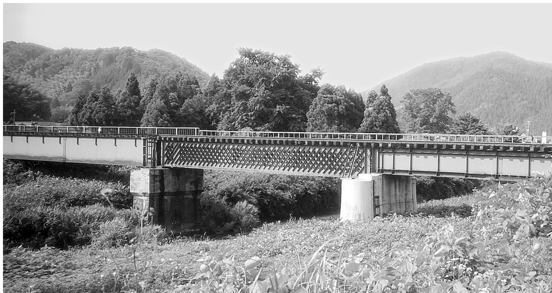
2級河川竹野川（兵庫県）に架かるラチス桁橋梁（山陰本線）
