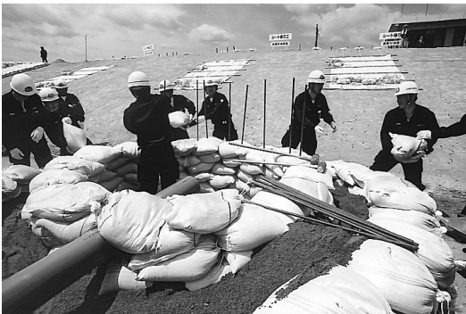
6/2 阿賀川水防演習 (釜段工)
