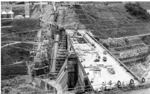
RCD工法による堤体コンクリート打設
