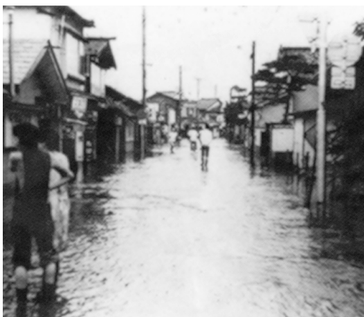
昭和51年8月洪水の浸水被害状況
