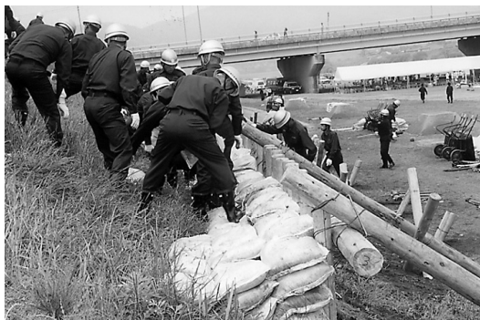
九頭竜川水系水防演習で杭打積み土のう工を実施する水防団員
