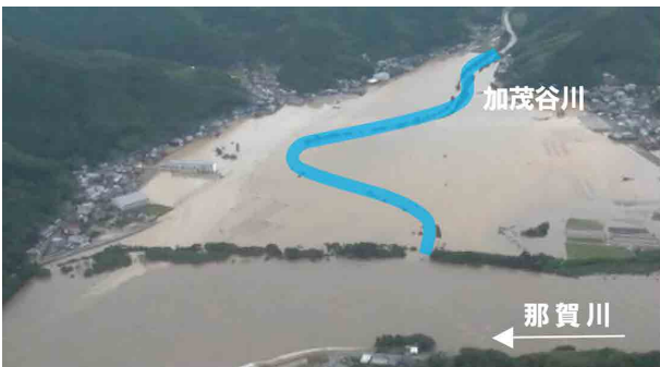
平成26年台風11号浸水状況（阿南市加茂地区）
