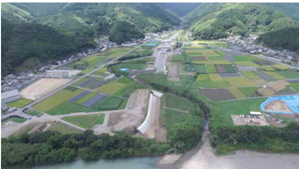
阿南市加茂地区 河道整備進捗状況（H30.8月）
