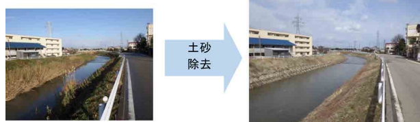
堆積土砂除去の事例（金腐川：金沢市）
