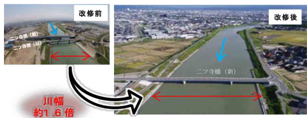
河川改修の事例（犀川：金沢市）
