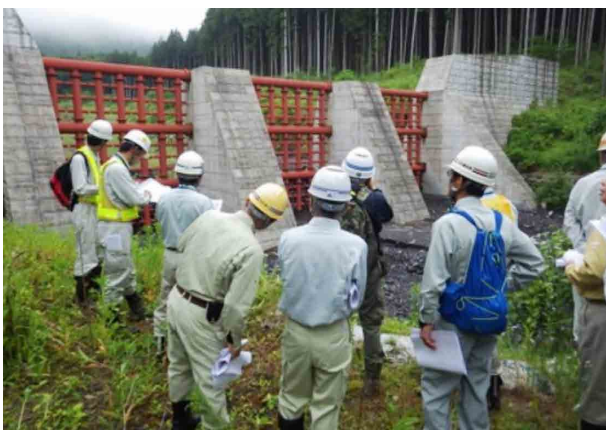
砂防設備合同点検（静岡県富士宮市）
