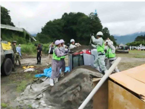
地元建設業協会による撤去作業 (三重県尾鷲市)
