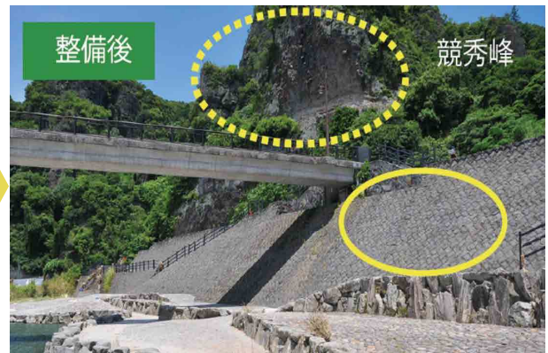
整備前後の青地区 (堤防護岸に、競秀峰と同じ凝灰岩を使用)
