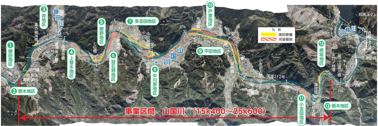
山国川床上浸水対策特別緊急事業区間
