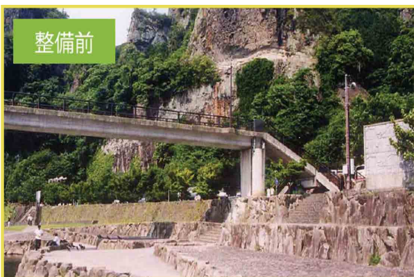
整備前後の青地区 (堤防護岸に、競秀峰と同じ凝灰岩を使用)
