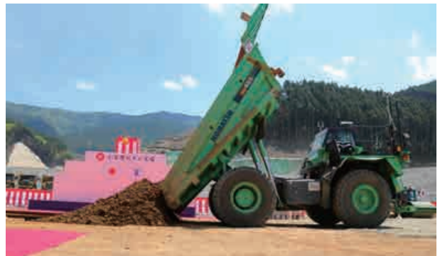
〈写真-9〉 自動化建設機械による埋納
