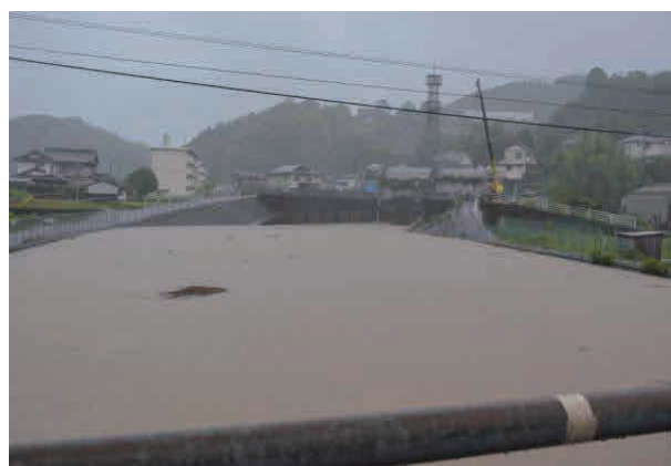
④日下川放水路（既設）の香口状
