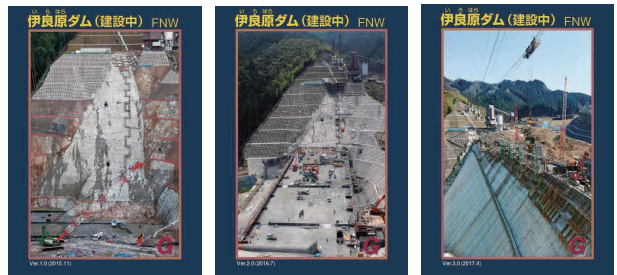
写真-4 今までのダムカード (建設中)
