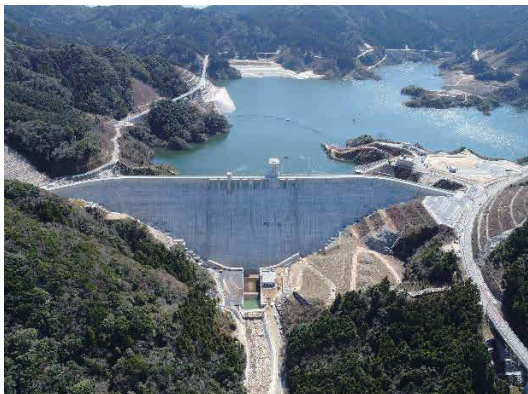
写真-3 五ヶ山ダム堤体
