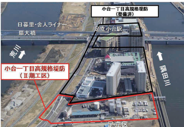
〈写真-10〉小台一丁目地区の現況
