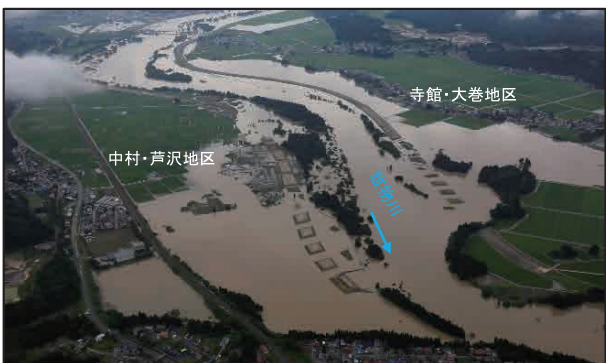
〈写真-3〉7月豪雨による浸水被害の状況（雄物川）
