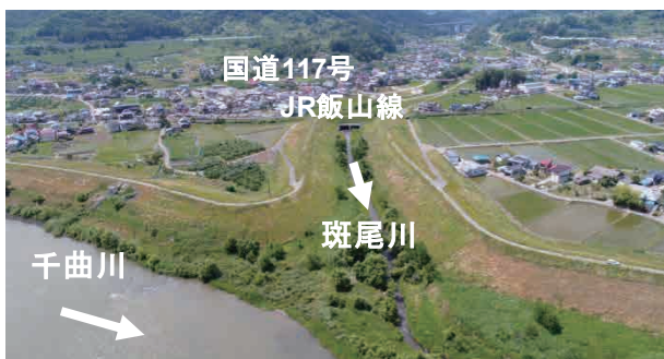
H28立ヶ花下流の堤防整備 (替佐地区)
