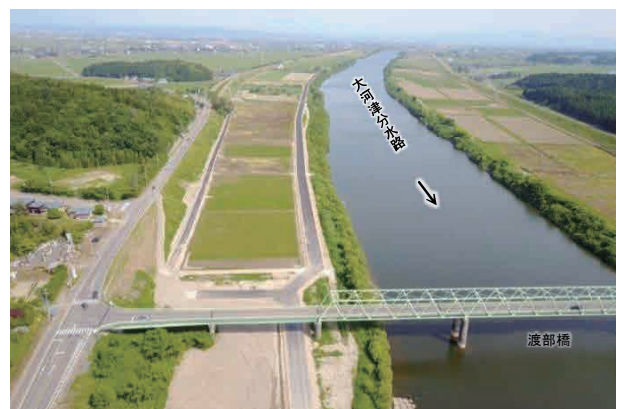
写真-2 工事用道路施工状況
