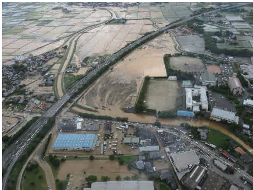
〈写真-2〉九州北部豪雨による浸水被害の状況（桂川）
