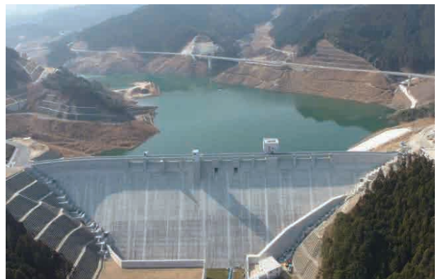
写真-6 試験湛水状況 (平成30年2月末時点)
