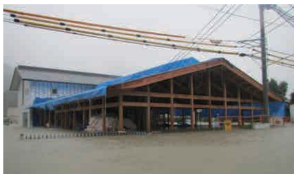
①完成前の「村の駅ひだか」浸水状況
