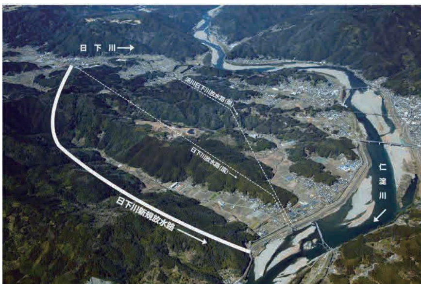
日下川新規放水路ルート
