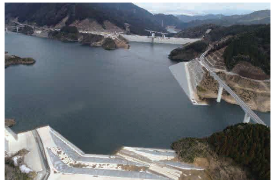
写真-4 試験湛水状況 (平成30年1月末)
