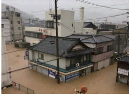
〈写真-5〉台風第 18 号による浸水被害の状況（津久見川）
