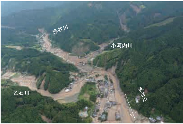
〈写真-1〉九州北部豪雨による土砂・流木による被害の状況（赤谷川）
