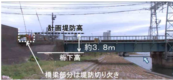
写真-4 計画堤防高と桁下高の関係
