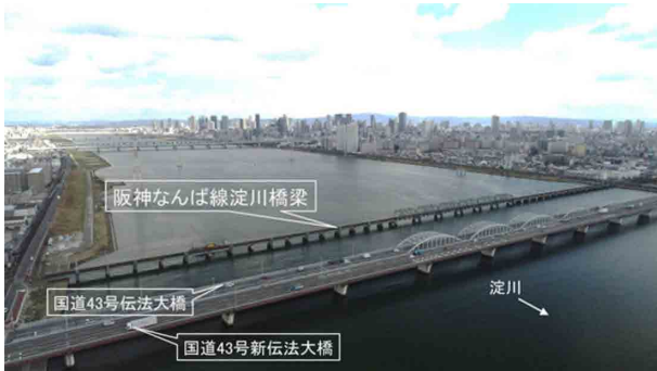
写真-1 阪神なんば線淀川橋梁 (大阪中心市街地を望む)
