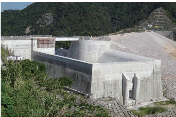
写真-3 洪水吐コンクリート打設完了 (H29.10.26 ダムサイト左岸上流より望む)
