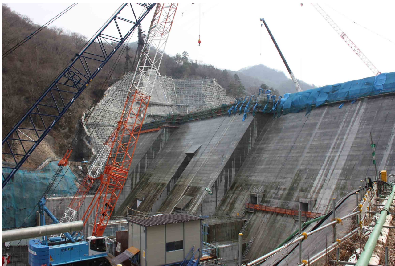
コンクリート打設が進む「ハツ場ダム」平成30年3月18日撮影
