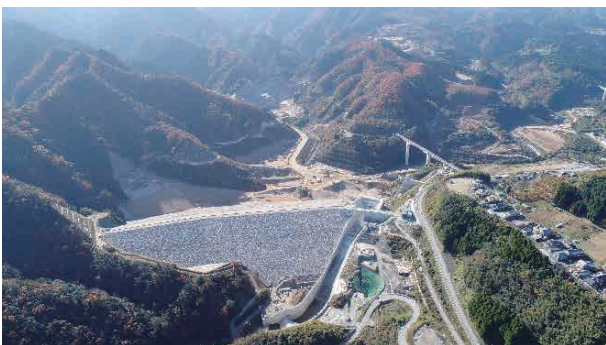
写真-5 試験湛水前の大分川ダム (H29.12.1 撮影)
