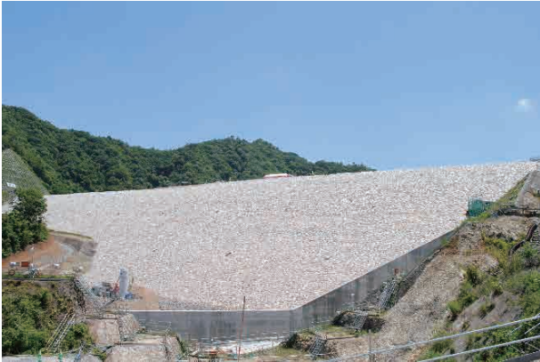
写真-2 ダム本体盛立完了 (H29.5.26 ダムサイト左岸下流より望む)
