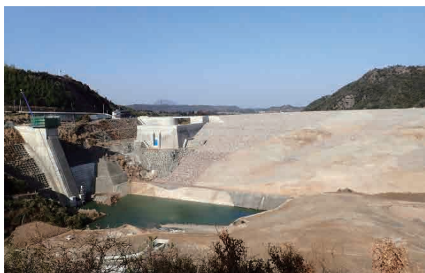
写真-10 試験湛水開始日の大分川ダム (H30.2.20ダム上流より望む)
