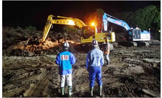
写真-14 24時間体制での土砂撤去状況（北海道厚真町）
