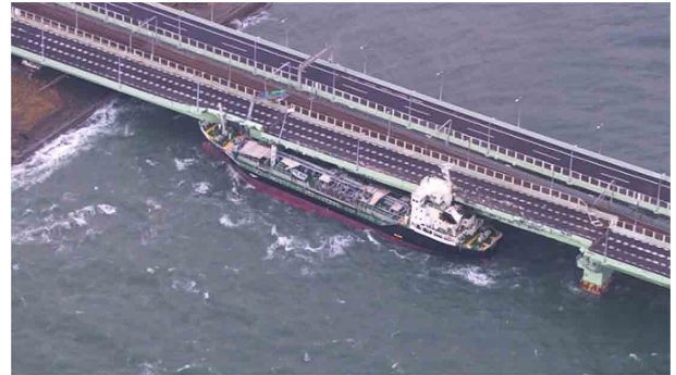
写真-5 関西国際空港連絡橋に衝突したタンカー
