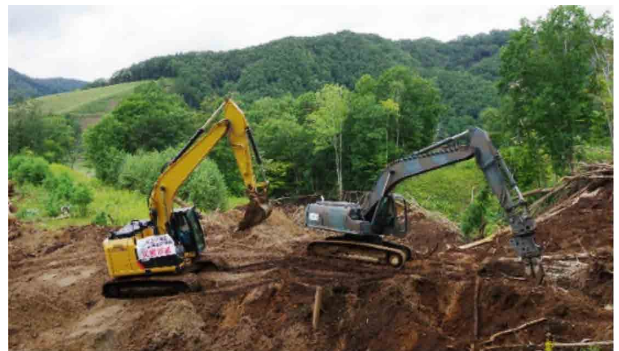
写真-15 自衛隊と連携した道路啓開（北海道厚真町）
