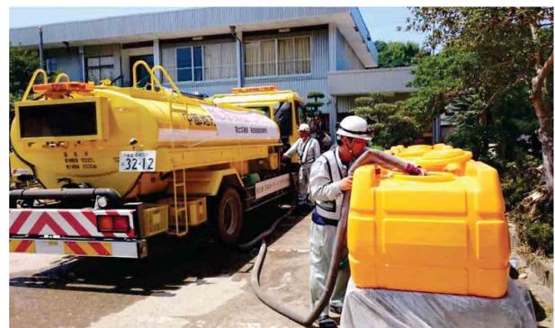
写真-11 散水車による給水 (愛媛県宇和島市)
