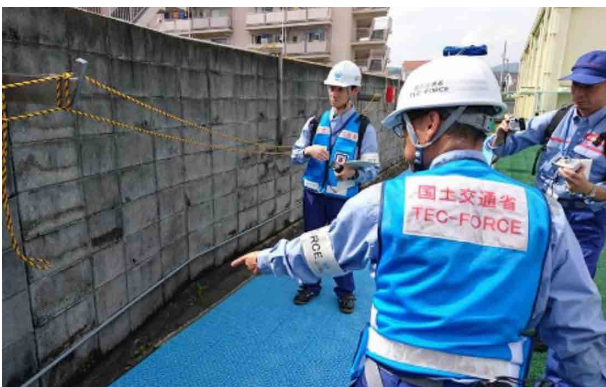
写真-4 ブロック塀の応急危険度判定 (大阪府高槻市)
