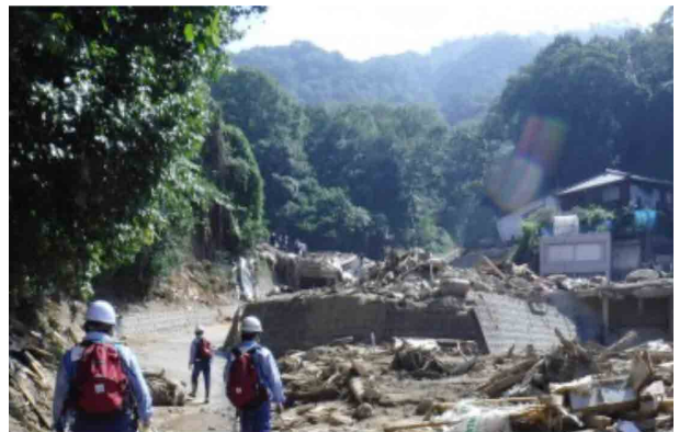
写真-7 土砂災害箇所における被災状況調査(広島県安芸区)
