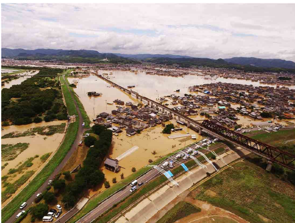
写真-6 緊急排水状況(岡山県倉敷市真備町)
