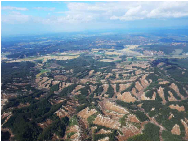
写真-12 大規模な崩落状況（北海道厚真町）
