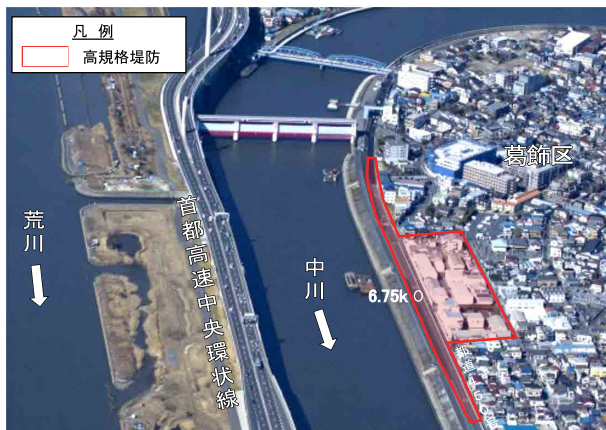
〈写真-5〉西新小岩地区の現況
