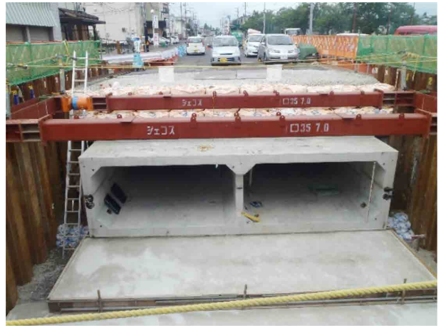
道路下の放水路本体 (B 8.2m x H 2.3m)
