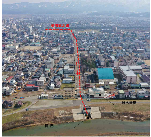
柿川放水路下流端より上流側をのぞむ
