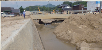
【平成29年7月九州北部豪雨】赤谷川復旧状況（福岡県朝倉市）
