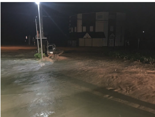
平成29年伊根町筒川（台風18号）
