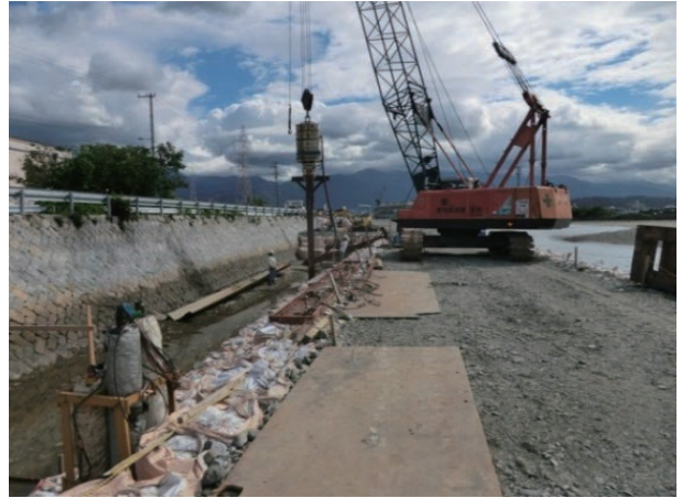
(二) 国領川（新居浜市） 堤防耐震対策工事
