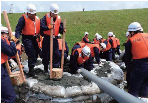
漏水防止工法(釜段工) (平成29年度狩野川連合総合水防演習・広域連携防災訓練)
