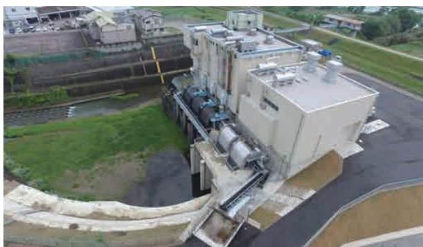
<図-1> 加茂川排水機場の全景。手前が増設部分
