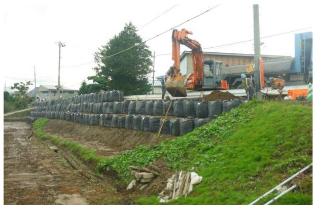
浸水防止緊急対策（大型土のう設置）状況
