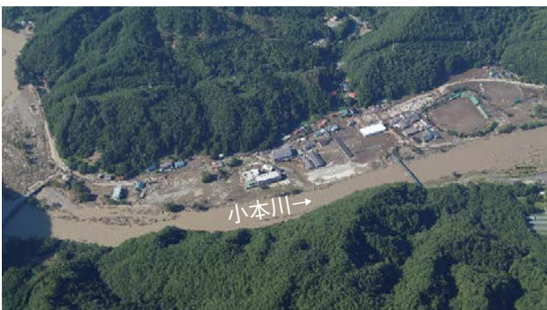
写真 -3 台風第 10号による浸水被害の状況 (小本川)
