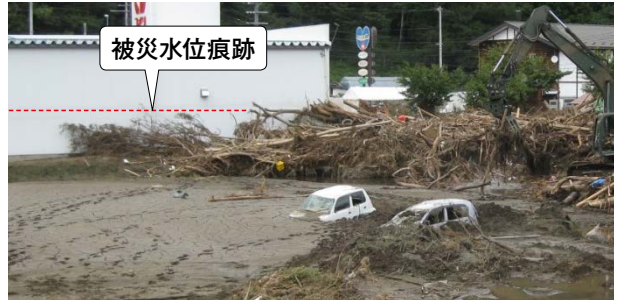
写真 -4 台風第 10号による浸水被害の状況 (小本川)
