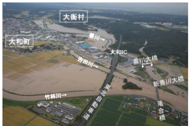
写真 -5 平成 27年関東・東北豪雨による浸水被害の状況 (吉田川)
