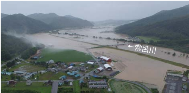
写真 -2 台風第 11号及び台風第 9号による浸水被害の状況 (常呂川)
