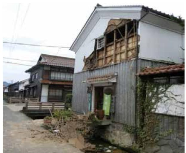
写真-5 白壁土蔵群における外壁の崩落状況(鳥取県倉吉市)
