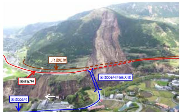
写真 -1 斜面崩壊による道路、鉄道の寸断
