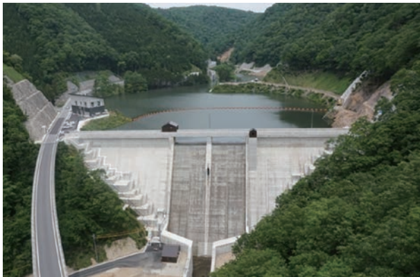
< 写真-1 > 庄原ダム全景
