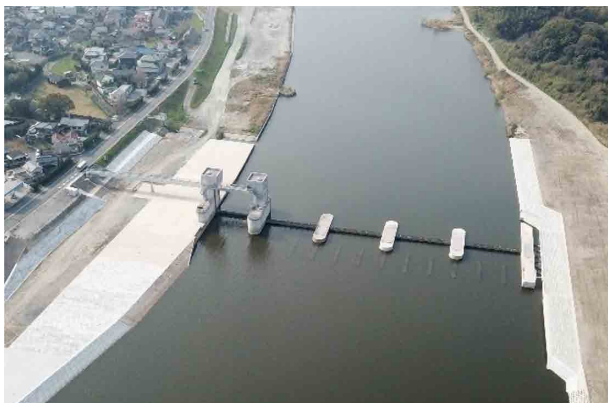
改築した中間堰
