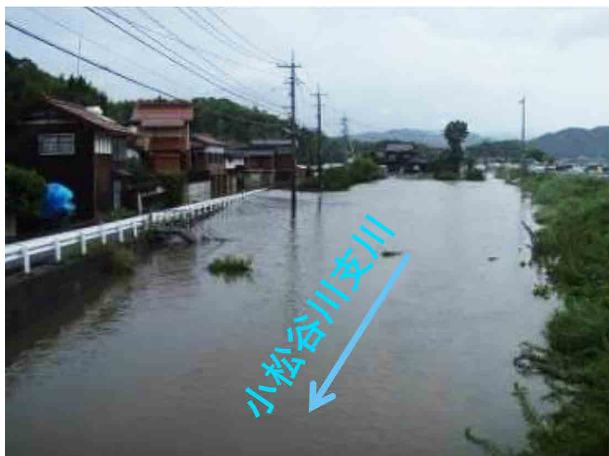
平成23年9月洪水による小松谷川支川の浸水状況
