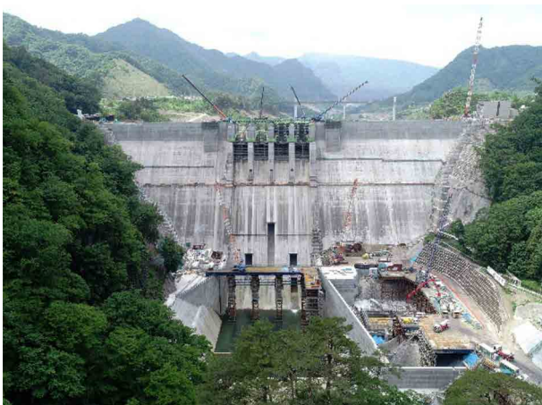
ハツ場ダム本体（下流から、R元.6）
