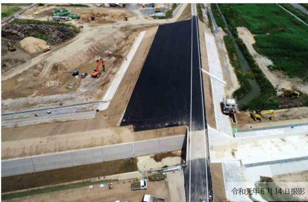
小田川3k400付近の決壊箇所の復旧完了状況
