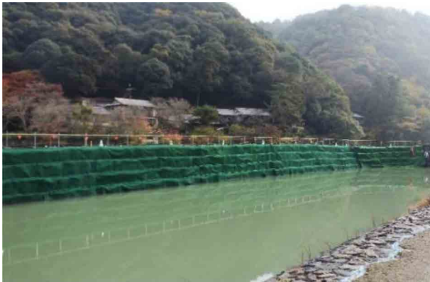
写真-7 大型土のうの景観対策
