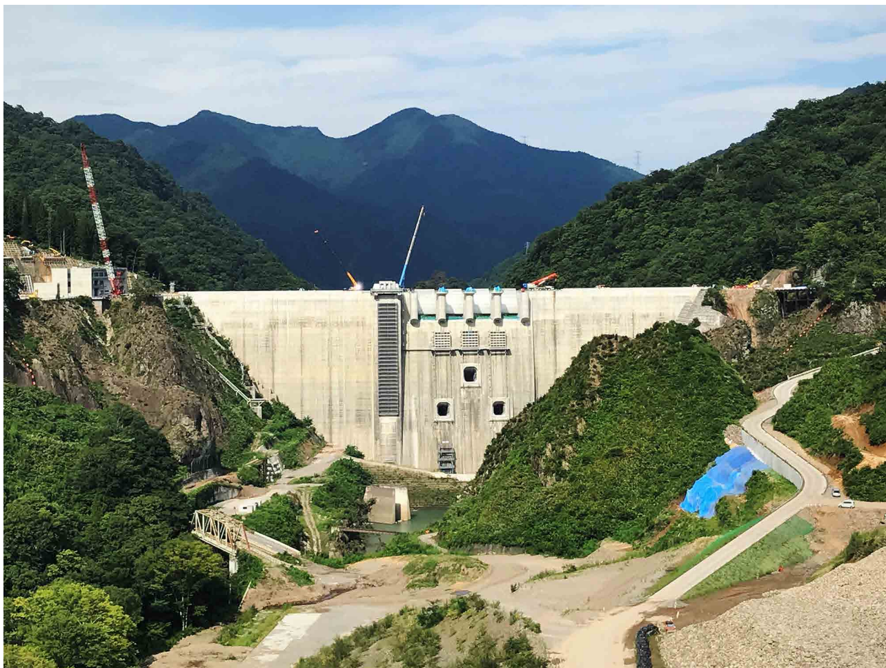
試験湛水を待つハツ場ダム (令和元年8月24日撮影)
