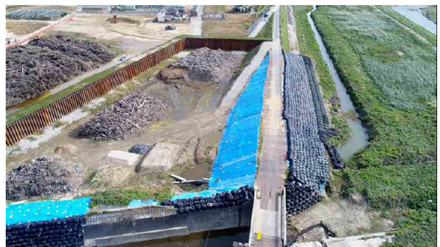
○工事準備中（平成30年10月31日時点：小田川左岸3K400）
