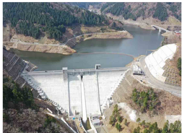
河内川ダム竣工写真
