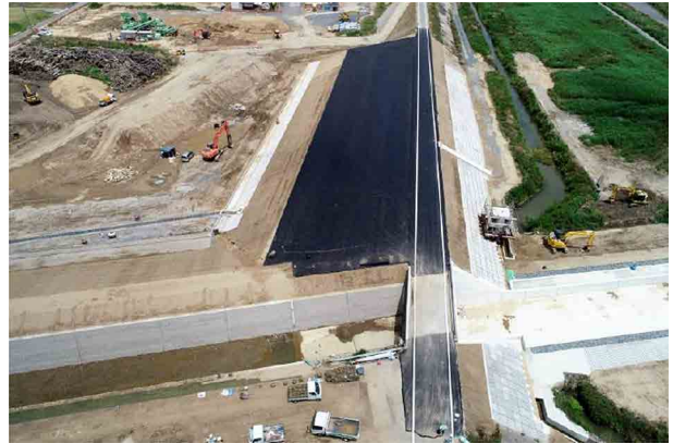
○本復旧堤防完成（令和元年6月14日：小田川左岸3K400）
