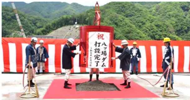
コンクリート最終打設
