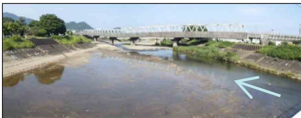
(写真3) 緊急対策による河床掘削（瀬戸川・焼津市）
