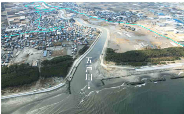
五戸川河口部の津波被害状況（平成23年3月12日撮影）
