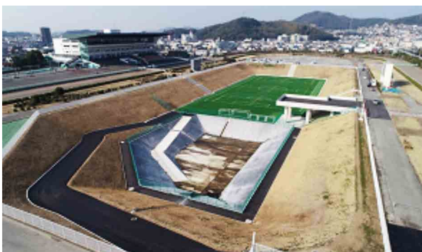
船場川調節池（姫路競馬場内）平成31年3月完成
