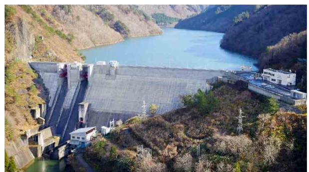
嵩上げ工事が完了した笠堀ダム
