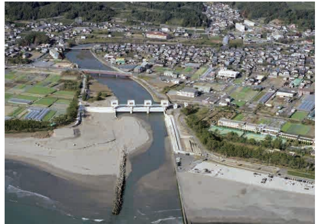
(写真4) 津波対策（勝間田川水門・牧之原市）
