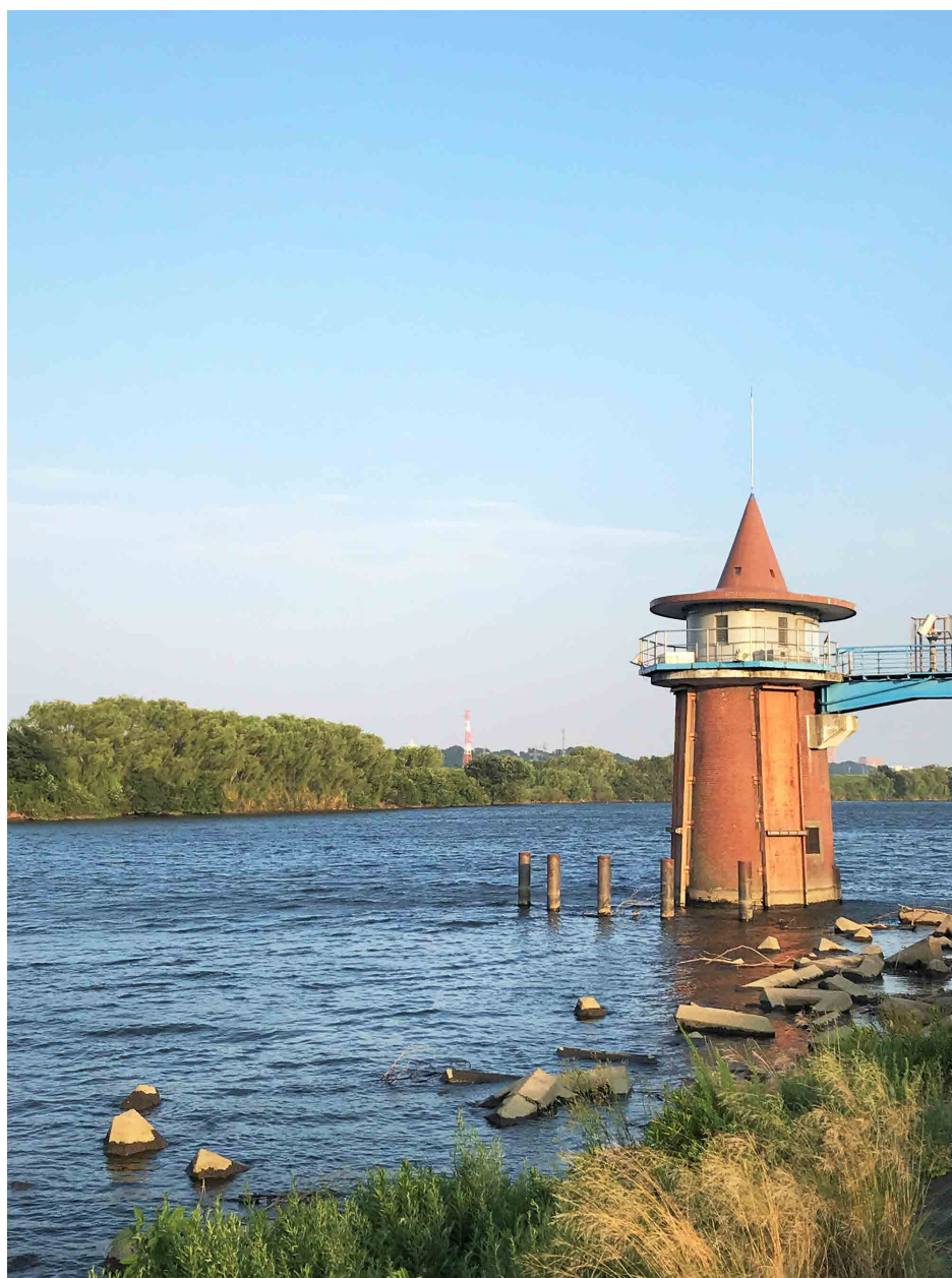
東京都葛飾区金町浄水場第2取水塔（江戸川右岸）
