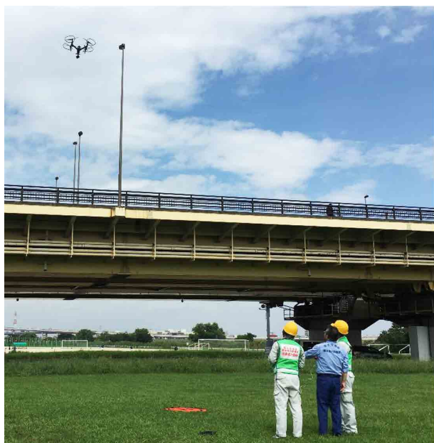
ドローンによる上空からの被害状況調査 (国道4号線)
