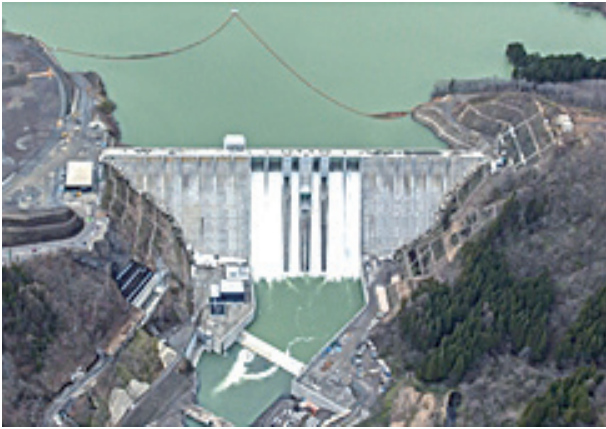
<写真-2>「洪水時最高水位に到達し、非常用洪水吐から越流している様子(試験湛水中、平成 28 年 4 月)」
