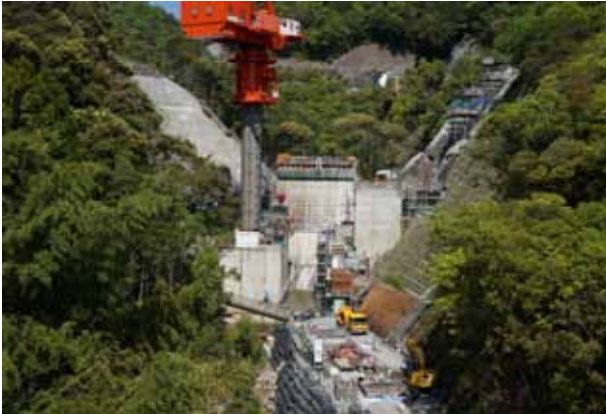
建設の進む和食ダム
