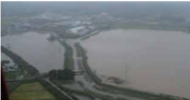
豪雨によって破堤した広田川の氾濫状況（幸田町）
