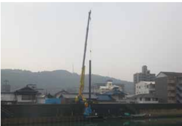
堤防耐震工事状況
