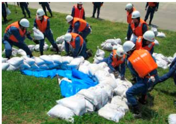
漏水防止工法（月の輪工） （第 65 回利根川水系連合・総合水防演習）
