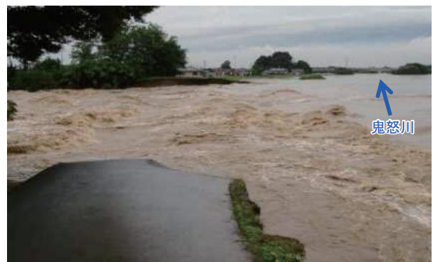
写真-1 堤防決壊状況(茨城県常総市三坂町地先)
