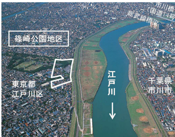
写真-7 篠崎公園地区の現況
