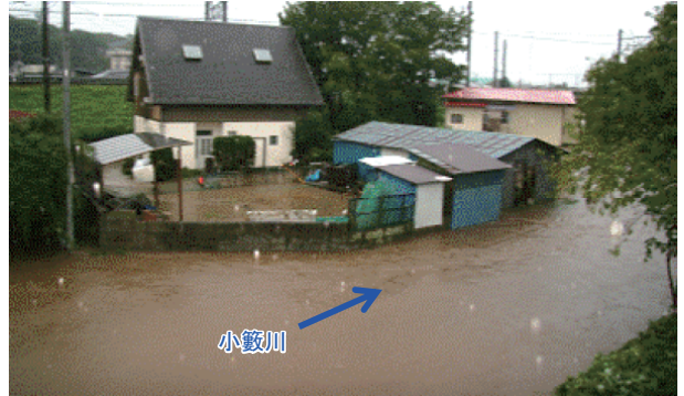
写真-5 溢水状況（栃木県鹿沼市西鹿沼地区）
