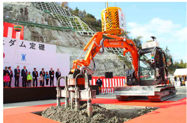
（写真10）無人化施工機械でコンクリートを締め固め
