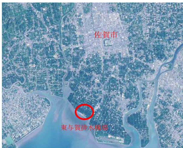
<写真-8>背後地を浸水から守る東与賀排水機場
