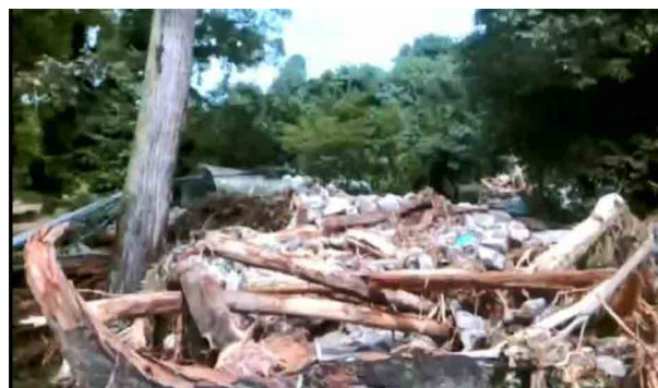
<写真-28>被災状況（金立川（佐賀県佐賀市））
