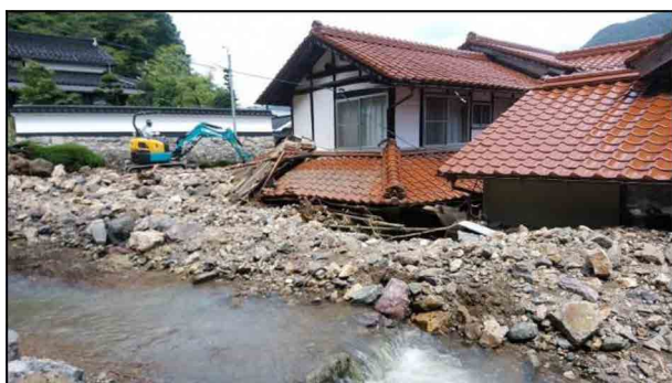
<写真-26>被災状況（今井谷川（岡山県新見市））
