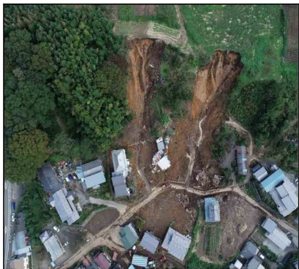
<写真-24>被災状況(内匠地区(富岡市))
