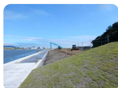
石巻市門脇町地区の堤防整備状況
