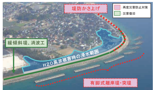
<図-11>富山県下新川海岸被災状況（平成20年2月24日）
