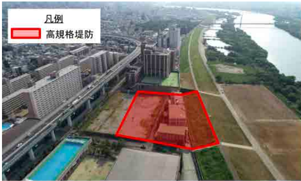
<写真-19>大宮東地区の現況
