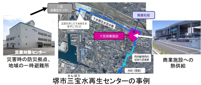
堺市三宝水再生センターの事例
