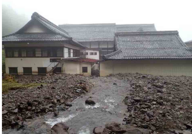
<写真-23>被災状況(女塩淵沢(嬭恋村))
