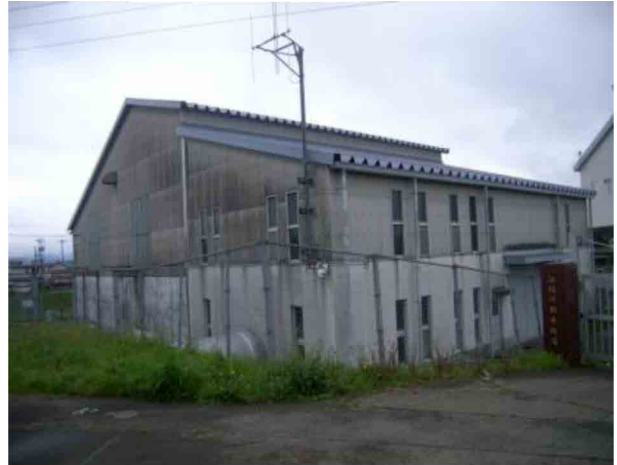
<写真-3>江端川第一排水機場
