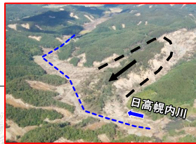
河道閉塞状況
