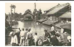
氾濫状況(埼玉県久喜市)
