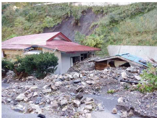
<写真-20>被災状況（平井賀の沢（田野畑村））
