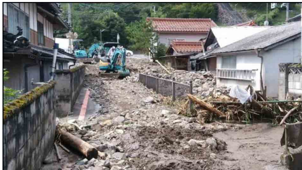
<写真-27>被災状況（太田川（岡山県新見市））
