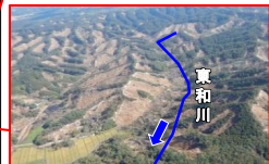
山腹崩壊発生状況
