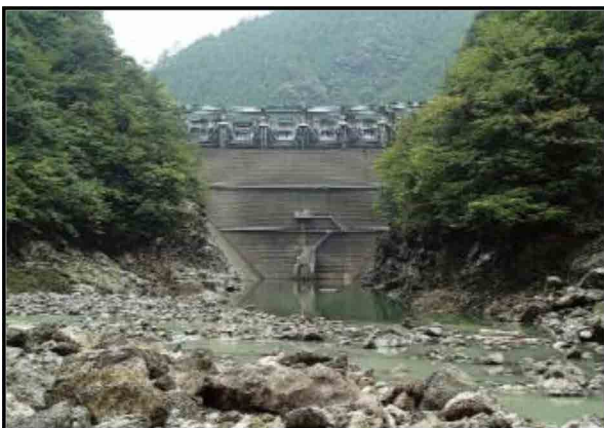
<写真-14>小見野々ダム (那賀川水系那賀川)
