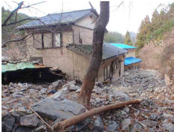
<写真-21>被災状況（尾崎白浜の沢（6）（釜石市））
