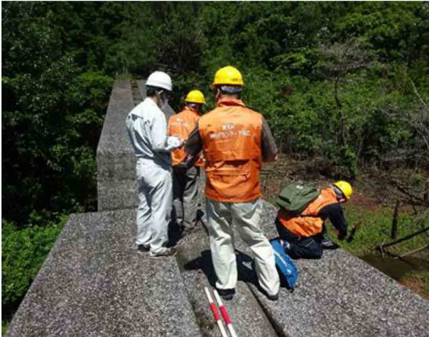
(写真-5) 令和元年度土砂災害防止月間における 砂防施設の点検状況
