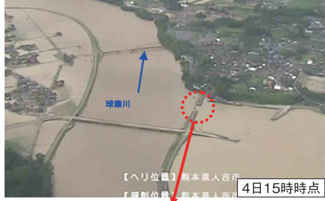
決壊箇所の状況
