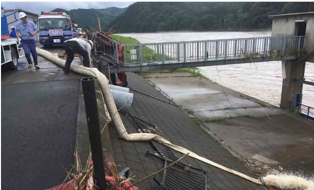
7月6日(月) 熊本県球磨郡球磨村の浸水箇所において、排水ポンプ車を設置し排水作業を実施 写真提供:国土交通省九州地方整備局
