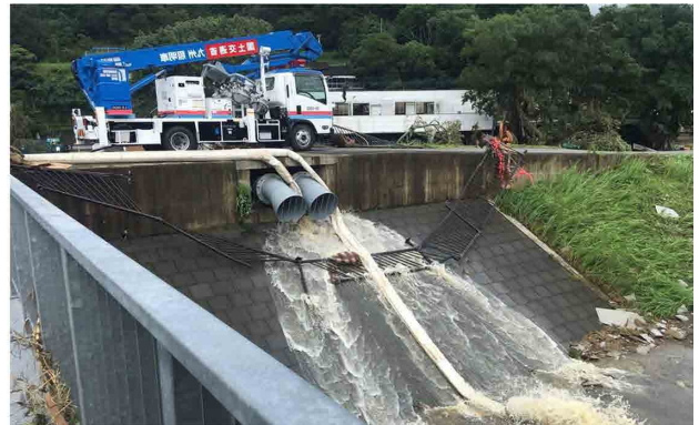
7月6日(月) 熊本県球磨郡球磨村の浸水箇所において、排水ポンプ車を設置し排水作業を実施 写真提供:国土交通省九州地方整備局
