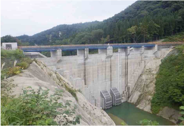
◆試験湛水開始前(通常時の状況)
