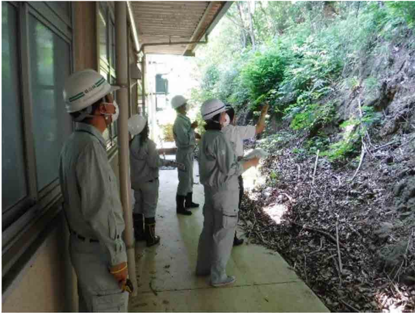
県・市の職員及び教員による学校裏山の急傾斜点検 (岡山県)
