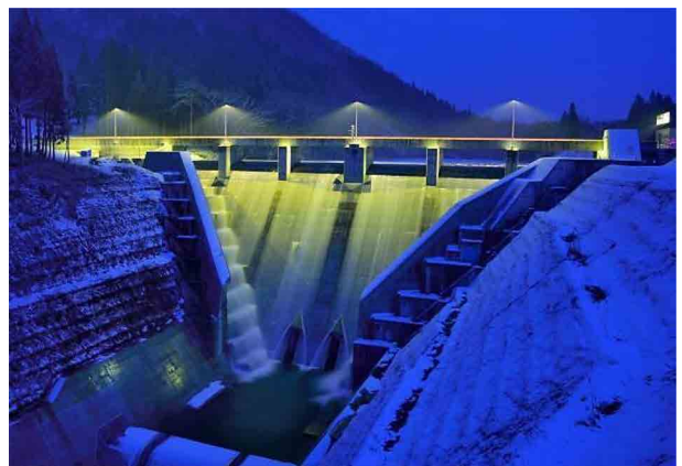
◆試験湛水により非常用洪水吐から越流する様子
