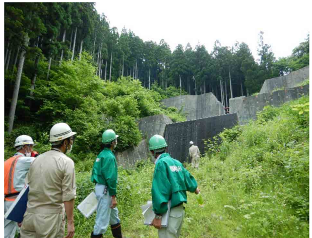
砂防設備点検(岐阜県)
