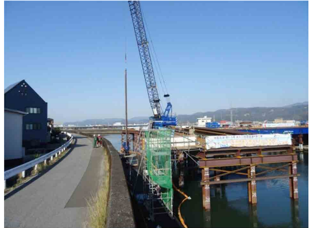
堤防耐震工事状況
