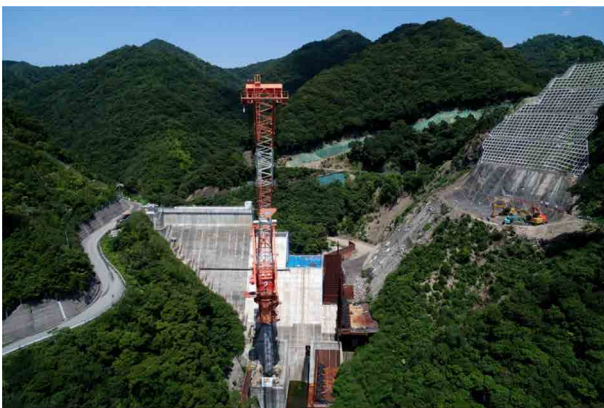
建設の進む和食ダム
