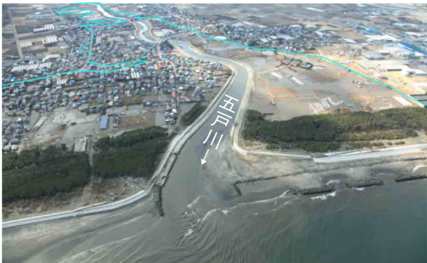
五戸川河口部の津波被害状況（平成23年3月12日撮影）
