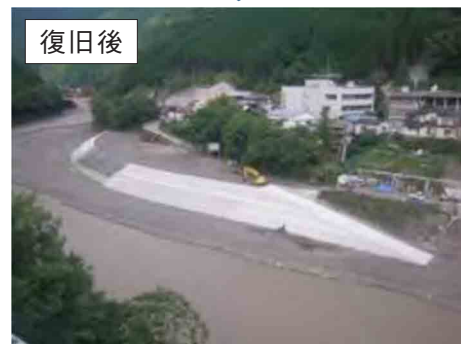
紀伊半島大水害 主な復旧箇所(十津川村武蔵地区)
