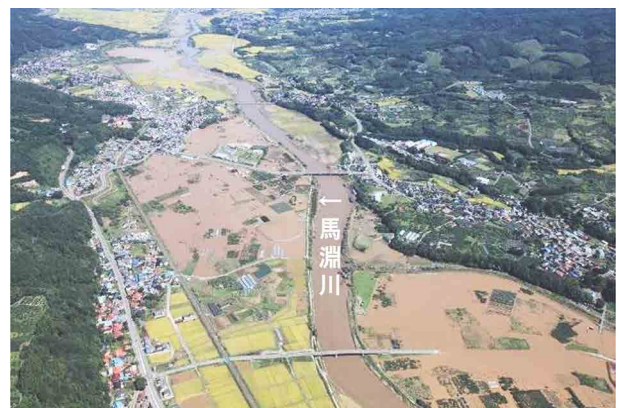
平成25年台風第18号による馬淵川浸水状況(南部町虎渡地区)
