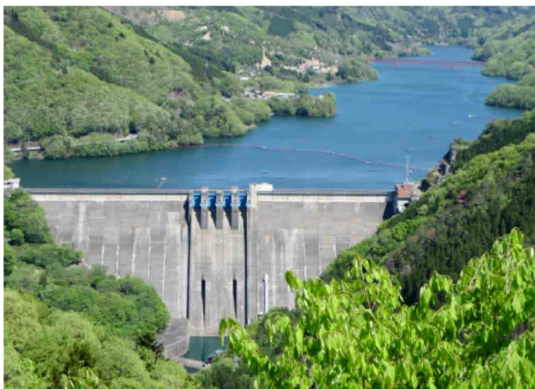
写真-1 令和元年台風第19号で大きな効果を発揮した草木ダム (水資源機構)
