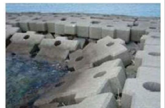
突堤の被覆ブロックの散乱事例
