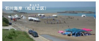
直轄事業で侵食対策として整備した、石川海岸(松任工区)の砂浜を海岸保全施設として指定。
