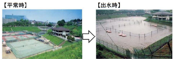
雨水貯留浸透施設の例(防災調整池)
