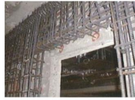
処理場の耐震化(躯体補強)
